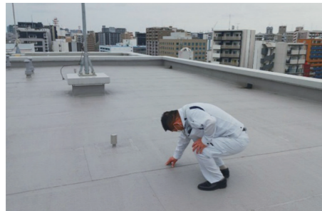
屋上に上がり、防水に不具合がないかの確認
