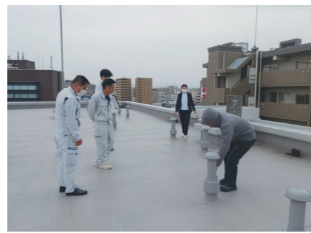
排気塔に錆が出ていないか確認
