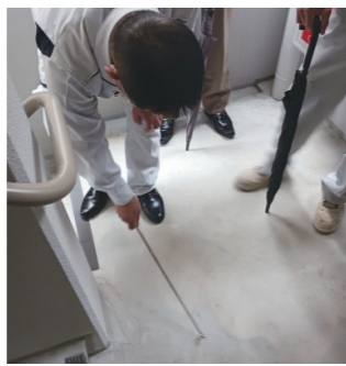
モルタルが浮いていないか確認
