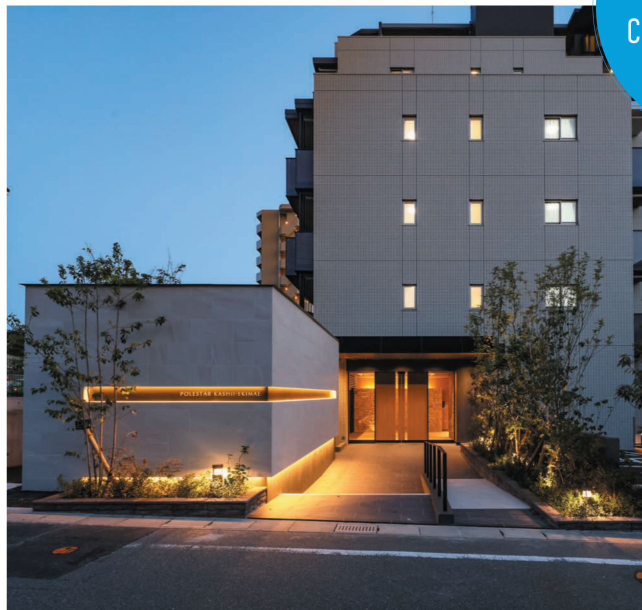
贅沢なアプローチが美しい 駅前の新たなシンボル
