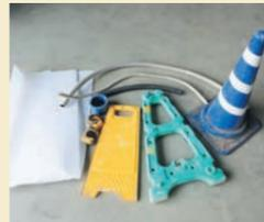
三角コーンや養生材、管やクランプなどの建設資材は、細かく破砕して再利用
