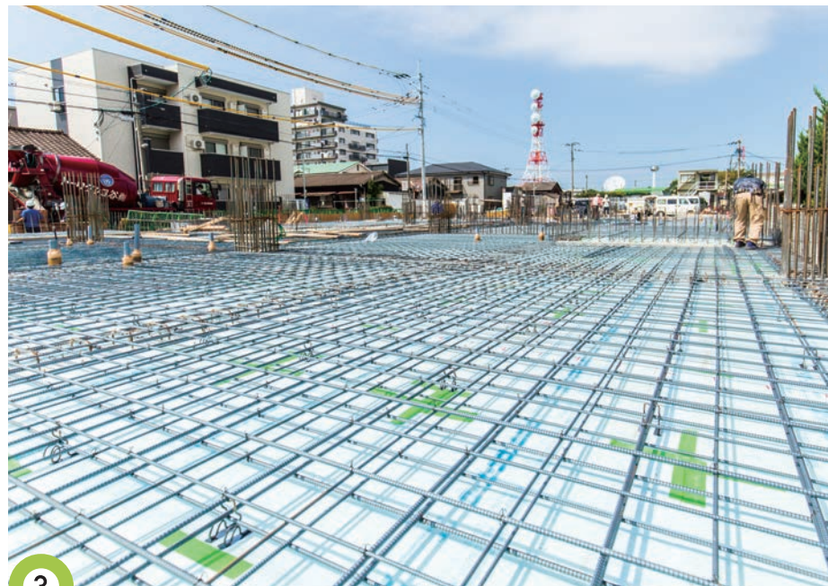
3 施工 現場には、格子状に規則正しく組み上げられた鉄筋が張り巡らされる。1本でも手順を間違えると鉄筋は正しく組めない。
