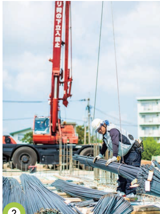
2 搬入 今回、搬入された鉄筋は1フロアあたり計50t。職人1人で70kg近くの鉄筋を担ぐこともある。
