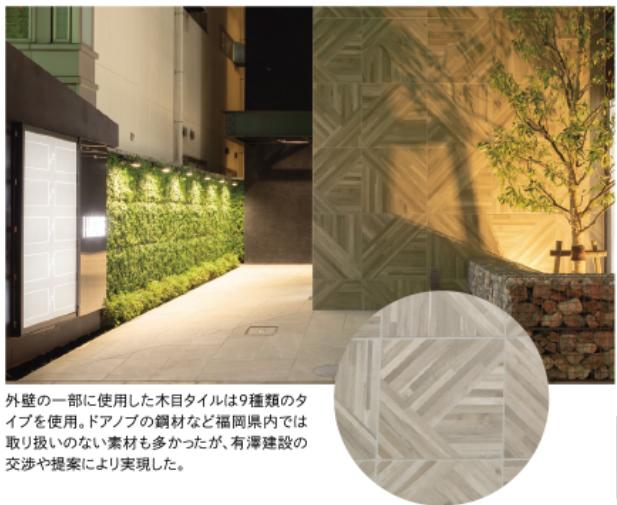
外壁の一部に使用した木目タイルは9種類のタイプを使用。ドアノブの鋼材など福岡県内では取り扱いのない素材も多かったが、有澤建設の交渉や提案により実現した。
