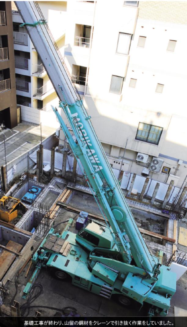
基礎工事が終わり、山留の鋼材をクレーンで引き抜く作業をしていました。
