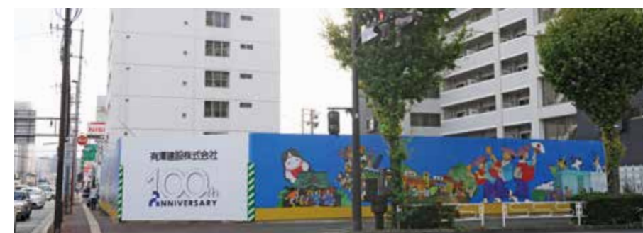
有澤建設本社新社屋建て替え建設地 仮囲い看板 福岡にまつわる様々なものを 新進気鋭のアーティスト「uwabamij」の手により、 全長約 50 mの巨大なキャンバスに表現。
