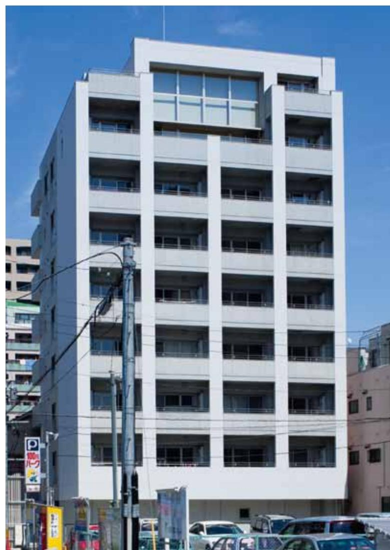
この建物の特徴として、内部、外部の仕上げの大半が、コンクリートの素地をそのまま、意匠とするものです。そのため、他の建物と比べてより注意する点は次のようなことです。まずは、施工図作成の段階で、型枠業者と入念な打ち合わせの上で、Pコン・パネルの割付図作成することから始まります。今回の場合、壁の両面が打ち放し部分が多く苦労しました。又、壁等にクラックが発生すると、そのままみえかがりとなり、漏水の原因ともなるため、誘発目地の設置位置も入念に検討しました。次に施工前に、コンクリート打設順序計画を作成し、打ち放し部分にコールドジョイント(打ち継ぎ)ができるような計画をします。施工段階では、コンクリート打設前の水洗いの徹底、打設中はジャンカ(豆板)ができるようにタタキを十分に実施しました。型枠解体中、解体後も傷をつけないように、注意・養生が必要です。コンクリート打ち放し仕上げの建物は、計画の善し悪しにより、建物の表情が変化するため、施工前の計画を入念に実施することが重要です。
