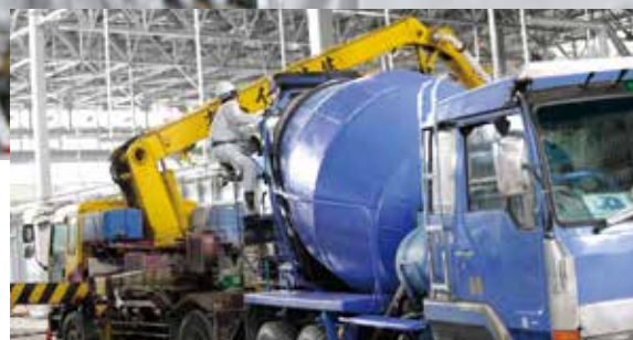
ミキサー車（右：青い車）が運んできた生コンクリートを、コンクリートポンプ車（左：黄色い車）が作業現場へ流し込みます。
