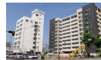
2015年5月末日解体が終了した本社屋建築地
