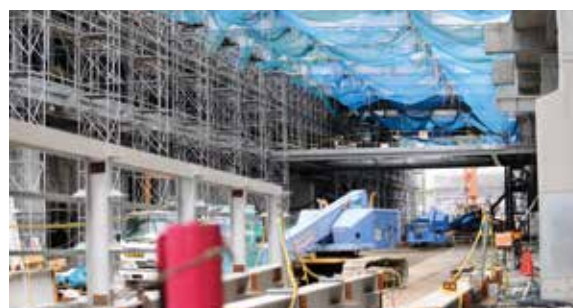
とても広い現場で、全国からかき集められた様々な種類の重機が至るところで活躍しています。
